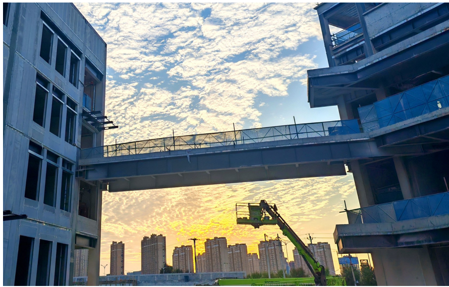
北京小学经开区学校项目进入精装修施工阶段。
