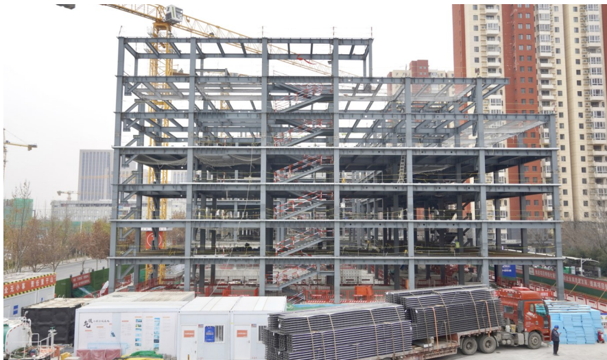
项目总建筑面积达3.8万平方米,地上六层,地下二层。
